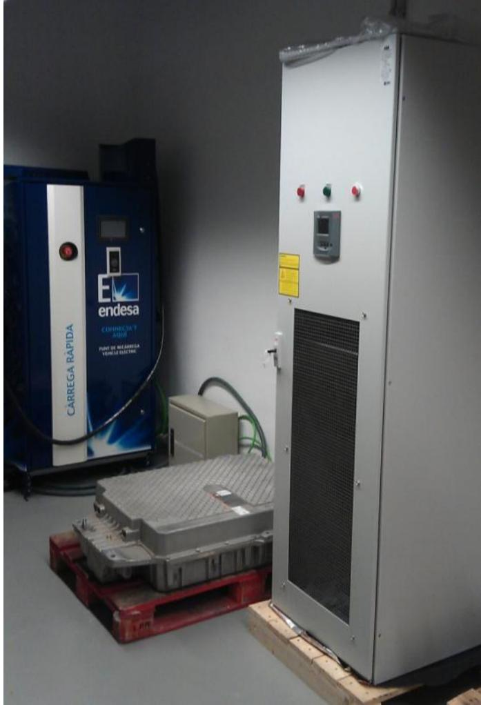
**2nd life batt + 40kW converter + 50kW Charger + gateway**
